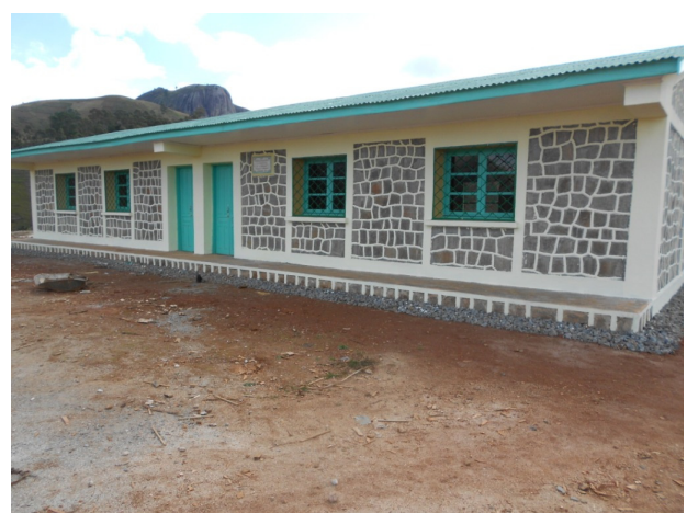
La façade avant
